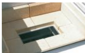
14. Osazení ohniště šamotovými plátkami
