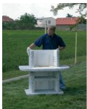
11. Postavení horní druhé bočnice
