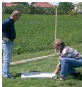
3. Položení základové desky na vyrovnanou plochu
