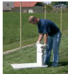
4. Postavení spodní bočnice
