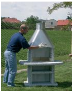
17. Osazení krbu střechou
