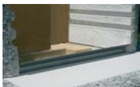
13. Usazení ochranného nerezového plechu na hraně topeniště
