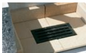
15. Vložení litinového roštu do topeniště
